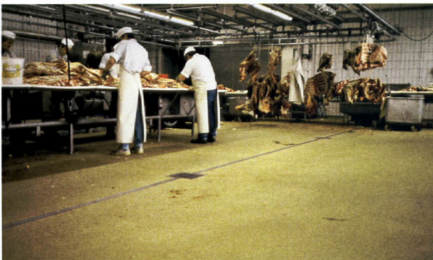
Reaktionsharz-Bodenbeschichtungen sind porendicht und fugenlos und lassen sich deshalb schnell und gründlich reinigen und desinfizieren.
