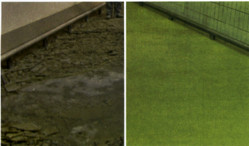
An nur einem Wochenende wurde der marode Altbelag dieser Schlachtstätte entfernt, aufgebaut und mit dem Polyurethanbetonsystem Ucrete neu beschichtet.
