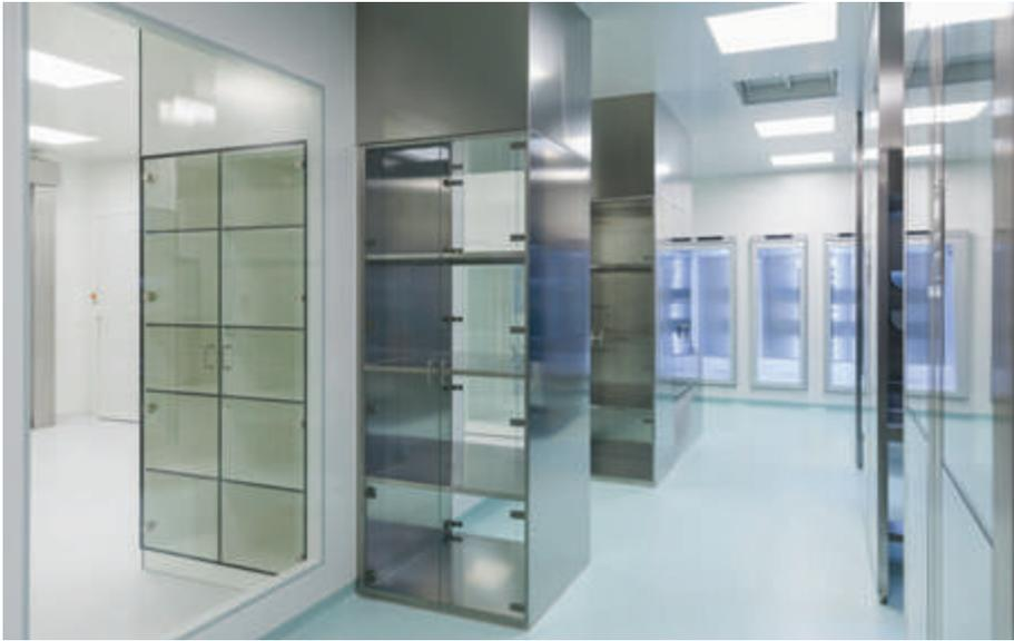
HPL bietet den Vorteil, dass es nassraumfest, hochschlagfest, kratzfest und leicht zu reinigen ist und gleichzeitig die Möglichkeit bietet, farbliche Akzente zu setzen. Edelstahl erfüllt alle wichtigen Anforderungen reinraumtauglicher Werkstoffe wie eine geringe Partikelemission, ist chemisch und mikrobiologisch beständig und ausserdem hydrophob. Edelstahl hat zusätzlich den Vorteil, dass es besonders langlebig und leicht zu reinigen ist.
