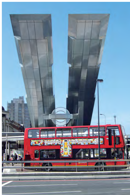
Für den Vauxhall-Cross-Busbahnhof in London wurde einer mustergewalzten Oberfläche der Vorzug gegeben, um den Reinigungsaufwand zu minimieren.
