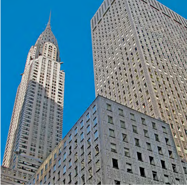
Das 1930 fertiggestellte Chrysler-Gebäude (links), stellte die erste großmaßstäbliche Anwendung nichtrostenden Stahls in der Architektur dar. Das Socony-Mobil-Gebäude (rechts) verfügte bei seiner Fertigstellung 1956 über die weltgrößte Edelstahlfassade. Beide Fassaden wurden erstmals 1995 gereinigt. Foto: Nickel Institute, Brüssel (B)/ Catherine Houska, Pittsburgh, PA (USA)
