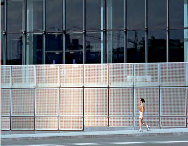
An der Fassade des Charlemagne-Bürokomplexes in Brüssel (B) hat sich gebürstetes und geschliffenes Lochblech bewährt.
