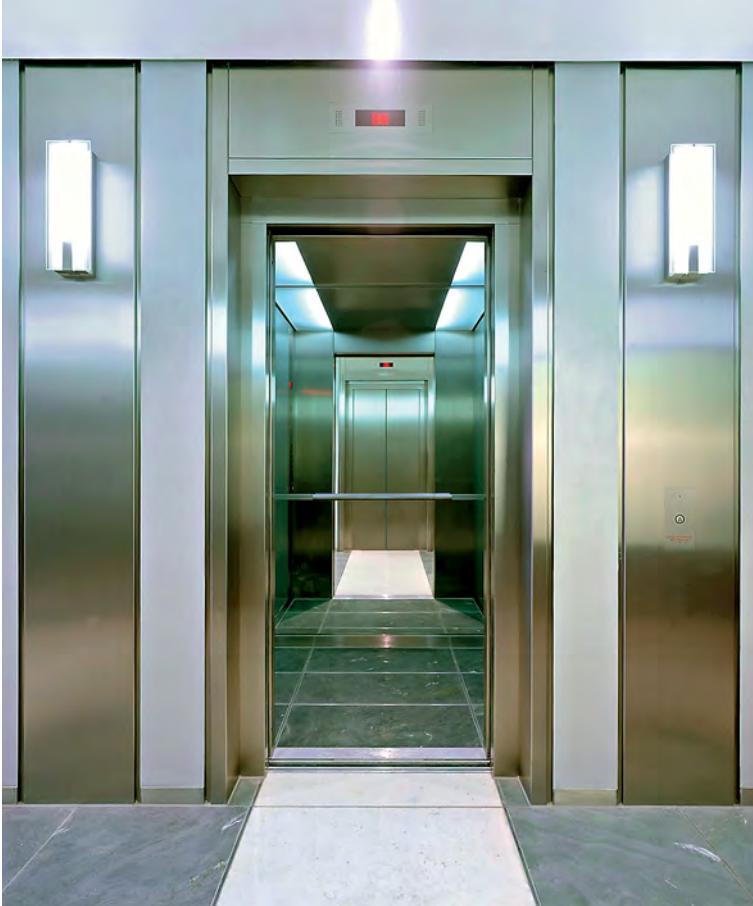
Ferritischer nichtrostender Stahl der Sorte 1.4016 mit einer aufgewalzten schliffähnlichen Oberfläche ergibt einen klassischen Seidenglanz. Foto: ThyssenKrupp Nirosta, Krefeld (D)
