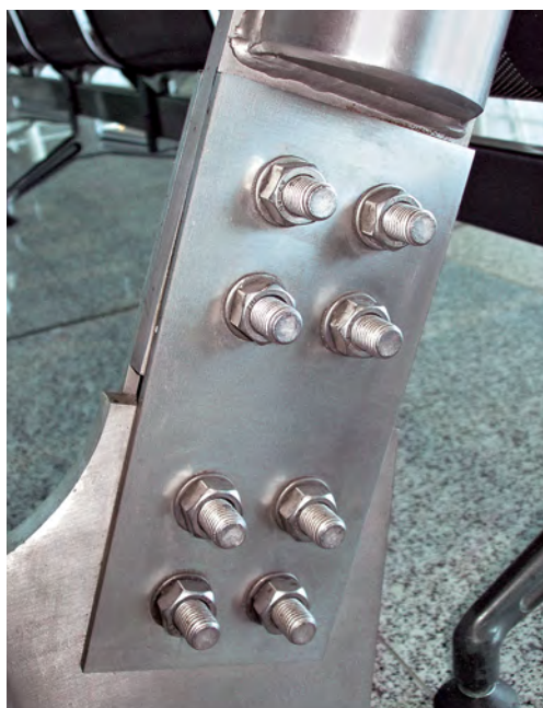
Edelstahl-Teile erfordern Edelstahl-Befestigungsmittel.
