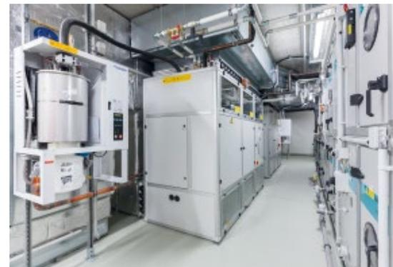
Abb. 6: Weiss Klimatechnik: Die Klimazentrale mit Weiss Umluft-Klimakompaktgeräten, zentraler Außenluftaufbereitungsanlage sowie separatem Befeuchtersystem
